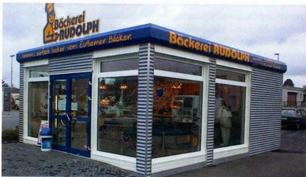
Alle Einbauten und Installationen sind im Rocon-Modul bereits fertiggestellt. Es muss nur noch transportiert und an Ort und Stelle abgeladen werden. Foto: Renz
